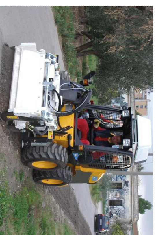
FRESATURA E RIMOZIONE DELLO STRATO DI USURA ESISTENTE E TRASPORTO IN DISCARICA
