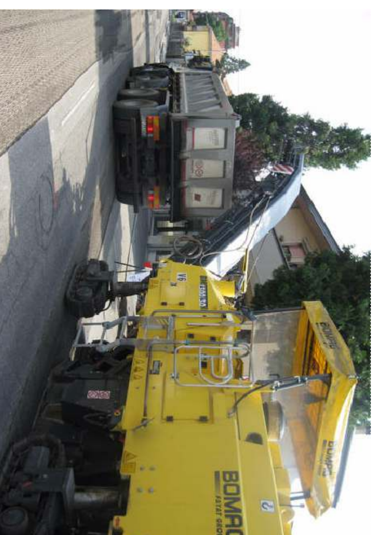
FRESATURA E RIMOZIONE DELLO STRATO DI USURA ESISTENTE E TRASPORTO IN DISCARICA
